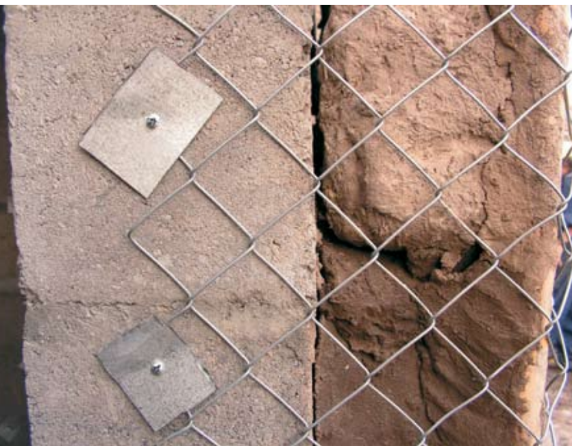
Proceso de construcción del prototipo Tarapacá: bloque de hormigón y revestimiento de adobe para lograr terminación tradicional.
